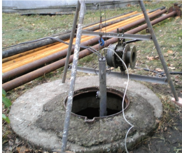
Відновлення дебіта водозабірної свердловини № 3754, розташованої в м. Ірпінь
