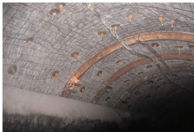
Виробки з анкерним (вгорі) та анкерно-рамним (внизу) кріпленням
