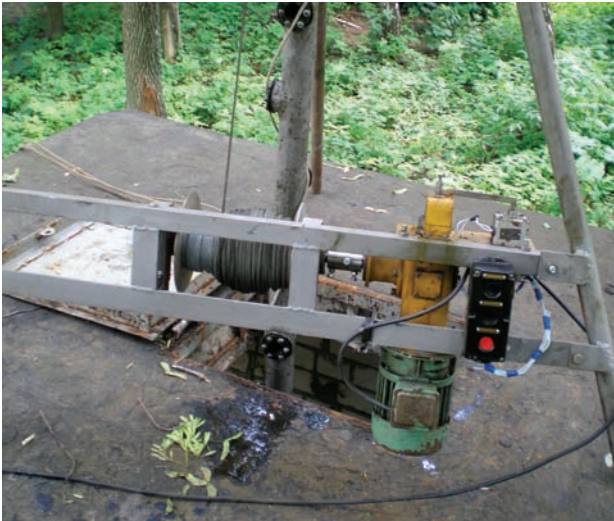
Відновлення дебіта водозабірної свердловини № 4513, розташованої в смт Буча
